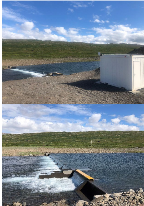
Mynd 5.6.9. Þvergirðing í Langadalsánni og myndatökubúnaður.
